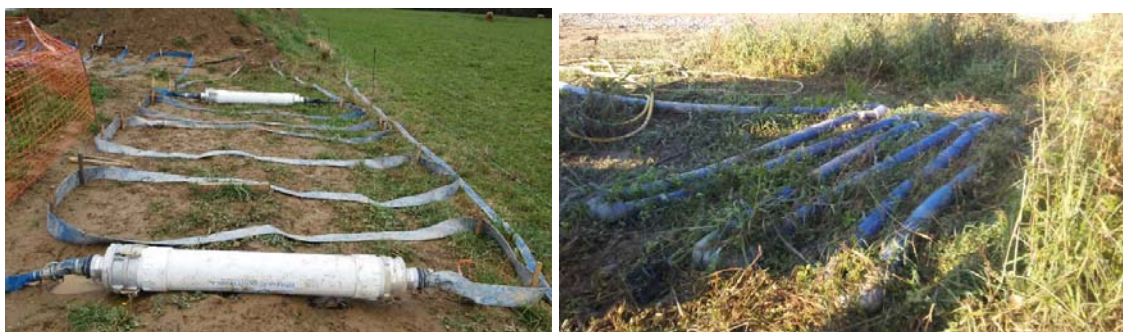
Figura 31. Sistema de dosificación.
