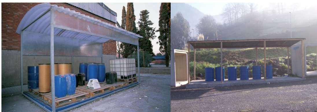
Figura 36. Ejemplos de punto limpio en construcción
