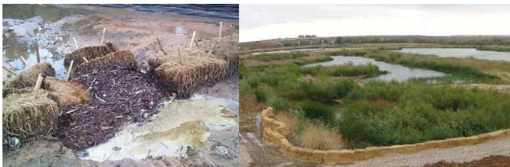
Figura 29. Balas de paja en mal estado (Izquierda). Balas de paja alineadas formando una barrera (Derecha).
