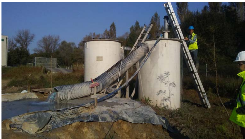
Figura 33. Sistema de agitación que trata las aguas previo al vertido de éstas sobre el decantador.
